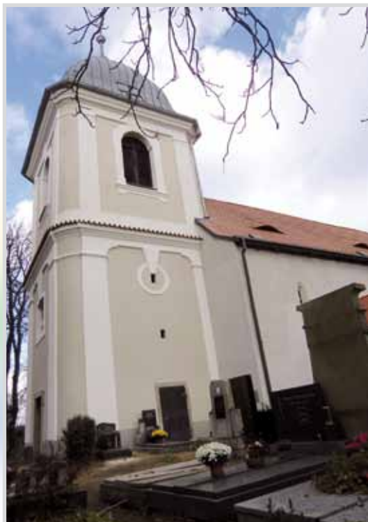
Obnovená střecha a fasáda kostela sv. Štěpána v Mýtě u Rokycan
