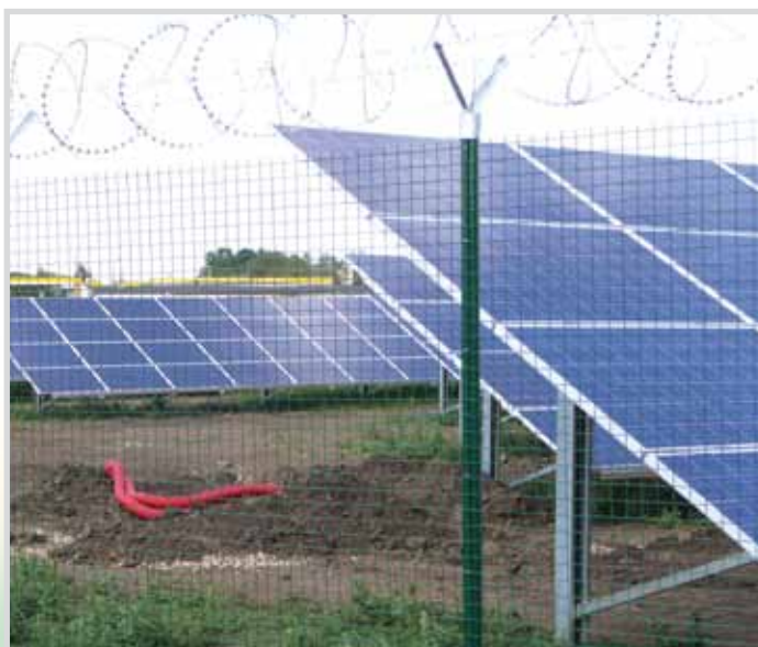
V roce 2010 bylo v Plzeňském kraji 83 fotovoltaických elektráren
