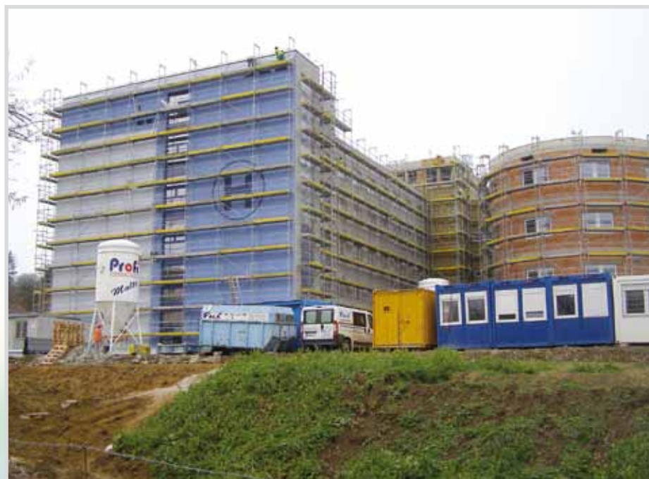
Výstavba nové klatovské nemocnice
