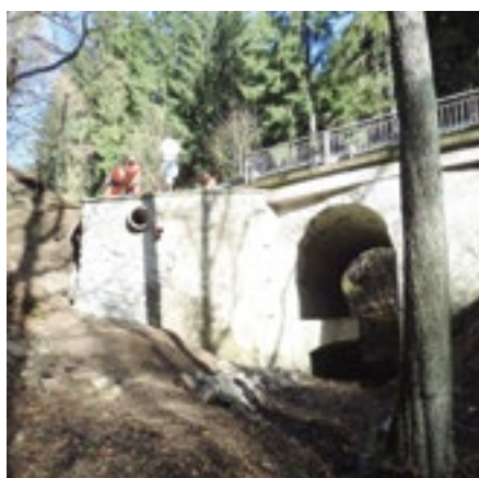
Stav po opravě.
