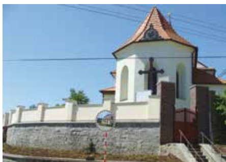
Akce s názvem Oprava čelní části ohradní zdi areálu kostela sv. Prokopa – Letiny. Realizováno obcí Letiny v roce 2013.
