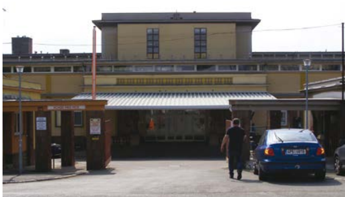
Stodská nemocnice před rekonstrukcí...
