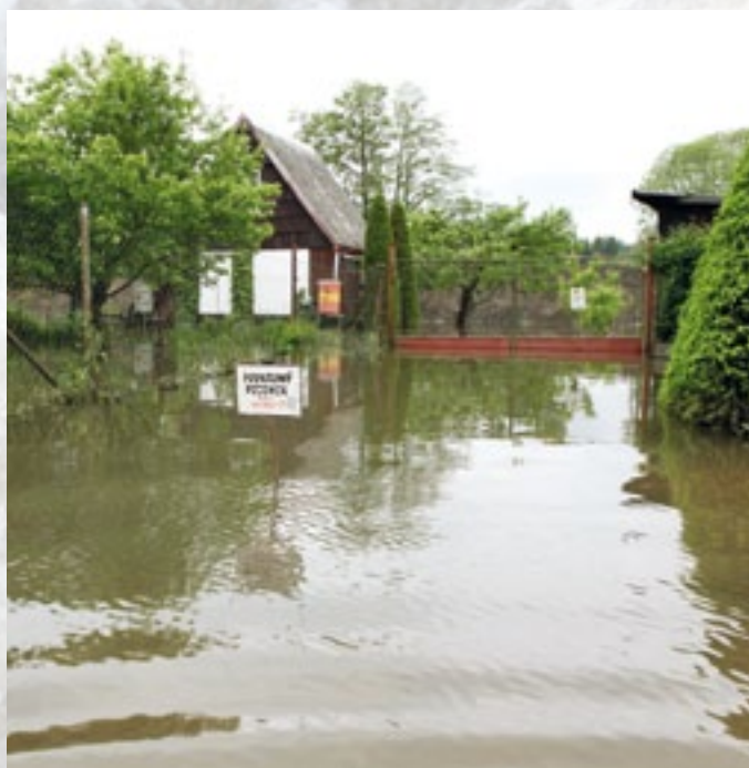
Povodní postižené oblasti v obci Hová Hut.
