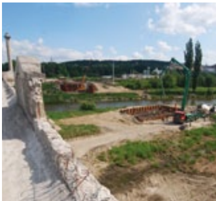
Most na Jateční přes Berouнку při letošních povodních skutečně rostl „z vody“, ale za normálních okolností stojí jeho pilíře na obou březích řeky.
