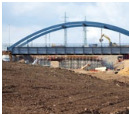
Západní obchvat Plzně bude mít Skvrňany v zářezu terénu, přes který se už klene nový železniční most.
