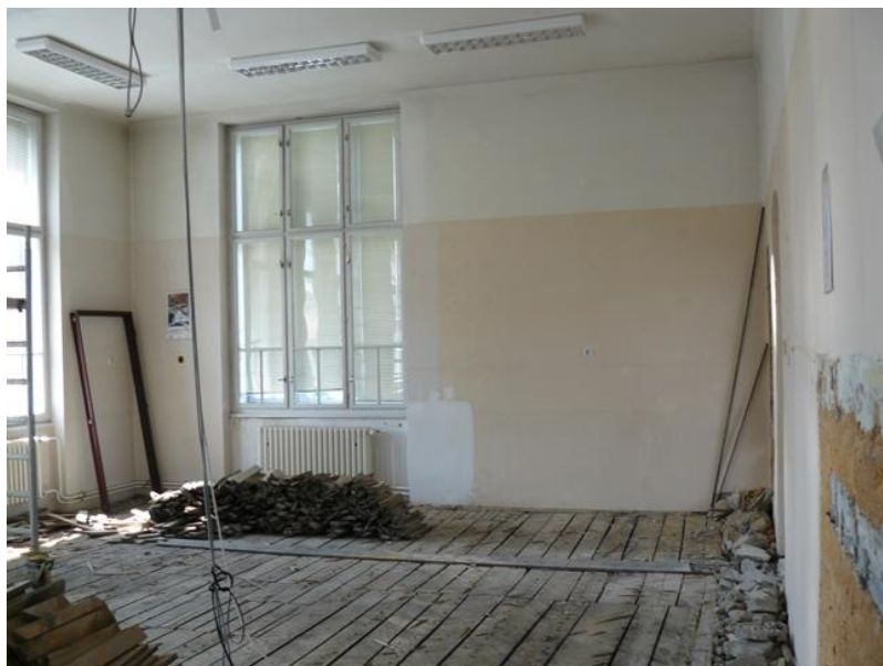
Obrázek 37: Průběh rekonstrukce laboratoře fyziky
