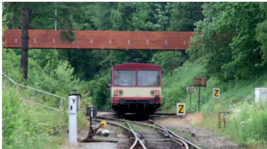
Akvadukt na Hadrovci.
