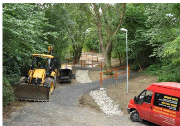
Vpravo: Stezka pro pěší a cyklisty v Domažlicích ve svažitém terénu s protidenudační úpravou
