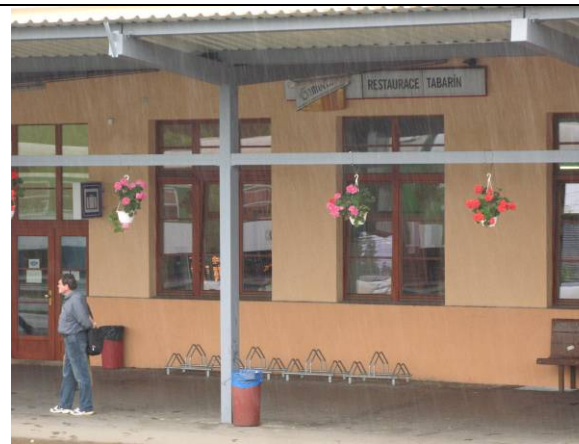
Příklad č.2 – Rokycany – nádraží po rekonstrukci
