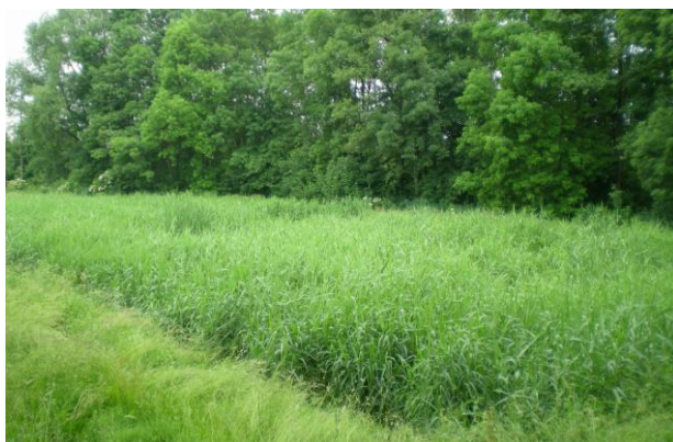
Obr. 20. Kořenová čistírna Spálené Poříčí (stará část). Foto Jan Vymazal.
