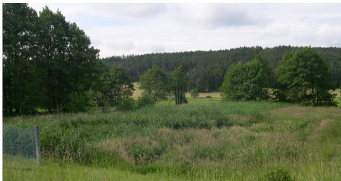
Obr. 21. Kořenová čistírna Ptenín. Foto Jan Vymazal.
