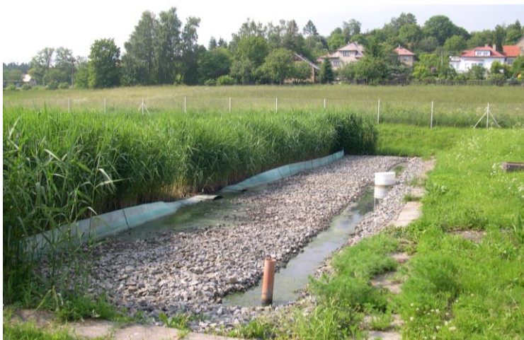
Obr. 11. KČOV Ondřejov byla uvedena do provozu v roce 1991 a je stále funkční. Foto Jan Vymazal.
