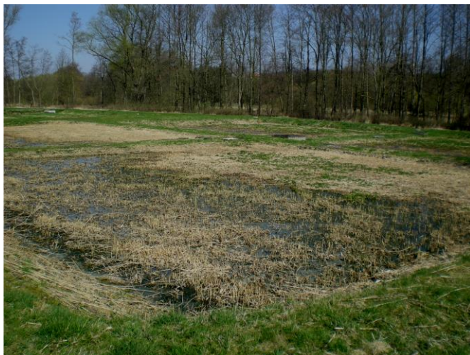
Obr. 15. Částečný povrchový odtok na KČOV Spálené Poříčí po šestnácti letech provozu v roce 2008. Foto Jan Vymazal
