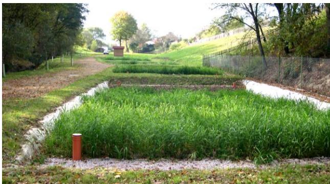
Obr. 23. Kořenová čistírna Němčovice. Foto Jan Vymazal.
