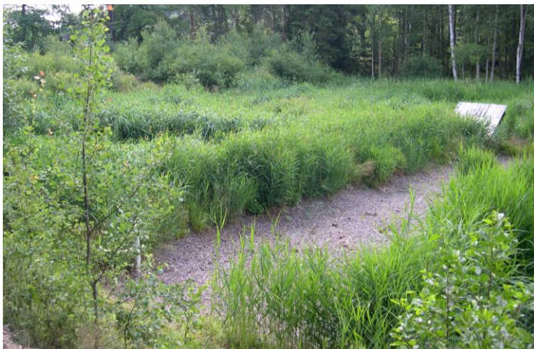
Obr. 26. Kořenová čistírna Sklárna-Žihle. Foto Jan Vymazal.
