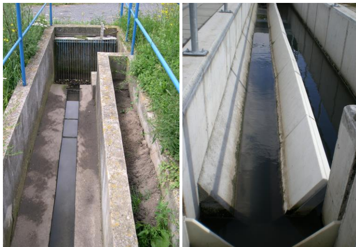
Obr. 7. Horizontální lapák písku. Vlevo žlabový lapák písku na KČOV Kámen u Havlíčkova Brodu, vpravo štěrbínový lapák písku na KČOV Ostrolovský Újezd u Českých Budějovic. Foto Jan Vymazal.
