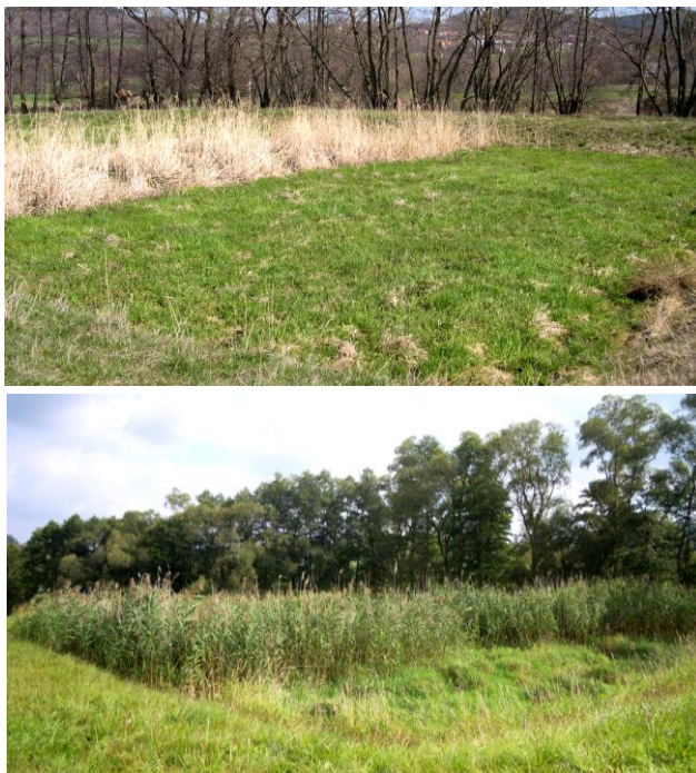
Obr. 25. Kořenová čistírna v obci Nezdice na Šumavě v roce 2004 (nahore) a v roce 2011 (dole). Na obrázcích je dobře vidět, jak porost rákosu (v pozadí) přerůstá porost chrostice.
