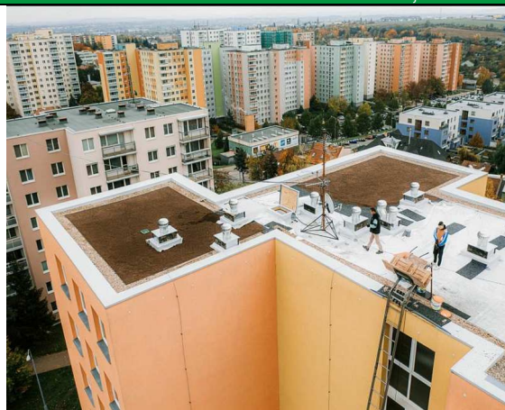
instalace extenzivní zelené střechy na panelovém domě v Brně, zdroj archiv GreenTop
