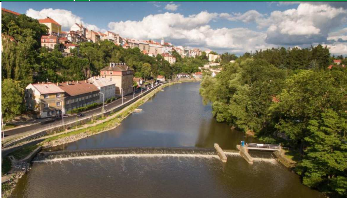
Protipovodňová zeď na levém břehu Lužnice v Táboře. Využití území mnoho prostoru pro přírodě blízká opatření neskýtá a zeď je jediné proveditelné řešení. Zdroj: eurovia.cz
