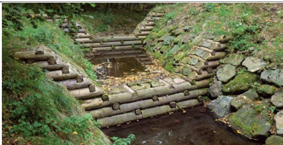
Soustava srubových stupňů se spadištěm opevněným ve březích kamennou rovnatinou (autor: Lesy České republiky, s. p.– Odbor vodního hospodářství).
