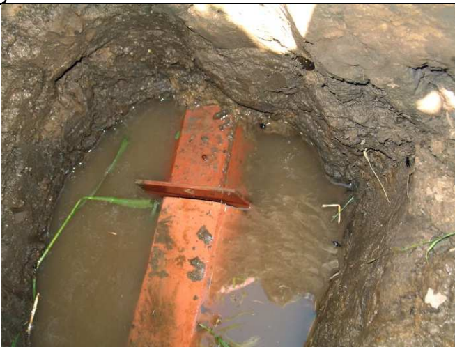
Obrázek 5 Eliminace funkce drénu záslepkou (foto: Z. Kulhavý)
