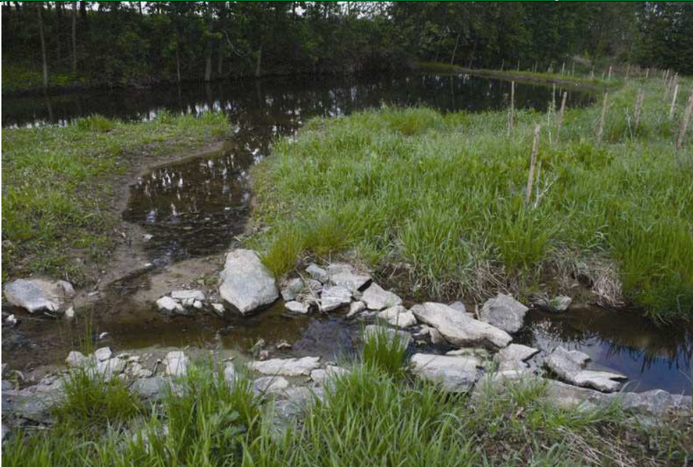
Obrázek 10 Rozdělovací objekt s přirozeným charakterem realizace, sloužící k odklonu vody pro zásobování boční tůně. Okr. Rychnov n. Kněžnou. (Foto: Z. Kulhavý)
