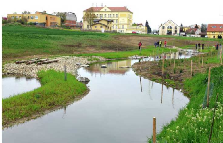
Revitalizace Litovického potoka v zastavěném území Hostivíc, realizace v roce 2015. Intravilánová stavba z vydlážděné strouhy v koprivách udělala zelenou osu města a dosáhla nečekaných revitalizačních efektů (zdroj: AOPK)
