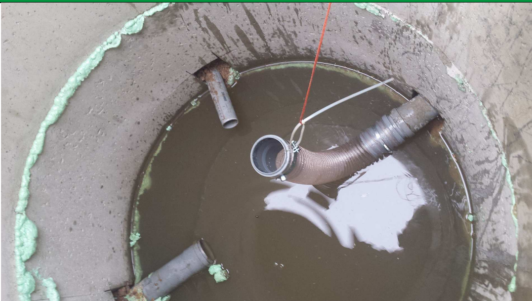
Obrázek 12 Příklad regulace odtoku v drenážní šachtici (foto: P. Fučík)
