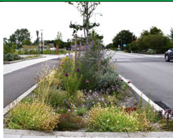
Záhon se speciální vpusť, Campus Vellinge, Švédsko, zdroj: atelier Edge, foto: Martin Vysoký 34
