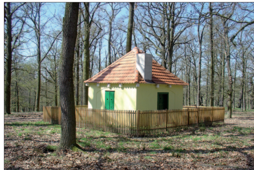
Nově opravený historický strážní domek Hubertka v oboře Podrážnice
