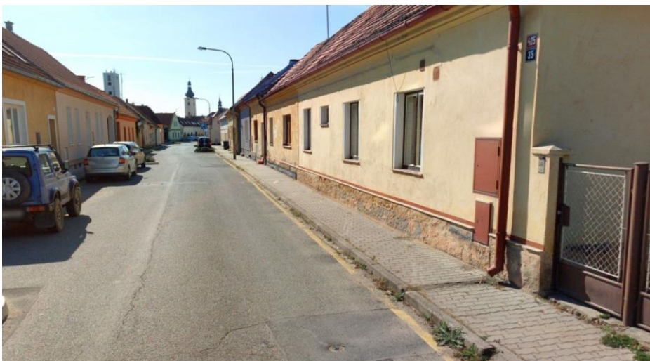
Příklad běžného zaústění dešťových svodů na ulici
