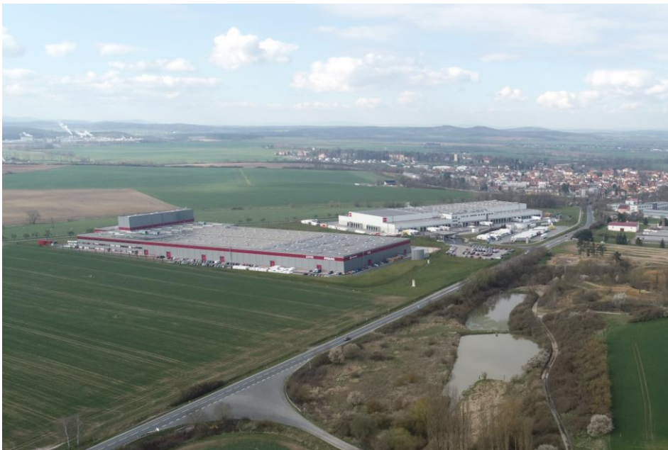
Rozhraní ve špatném stavu – ostrý přechod mezi průmyslovým areálem a okolní zemědělskou krajinou na východním okraji Dobřan
