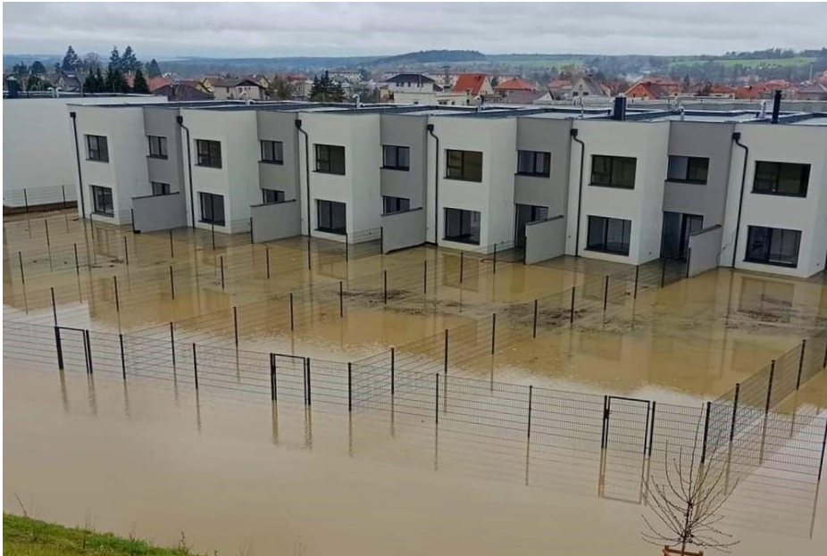
Zaplavení ploch v ulici Novákova (15.4.2023)
