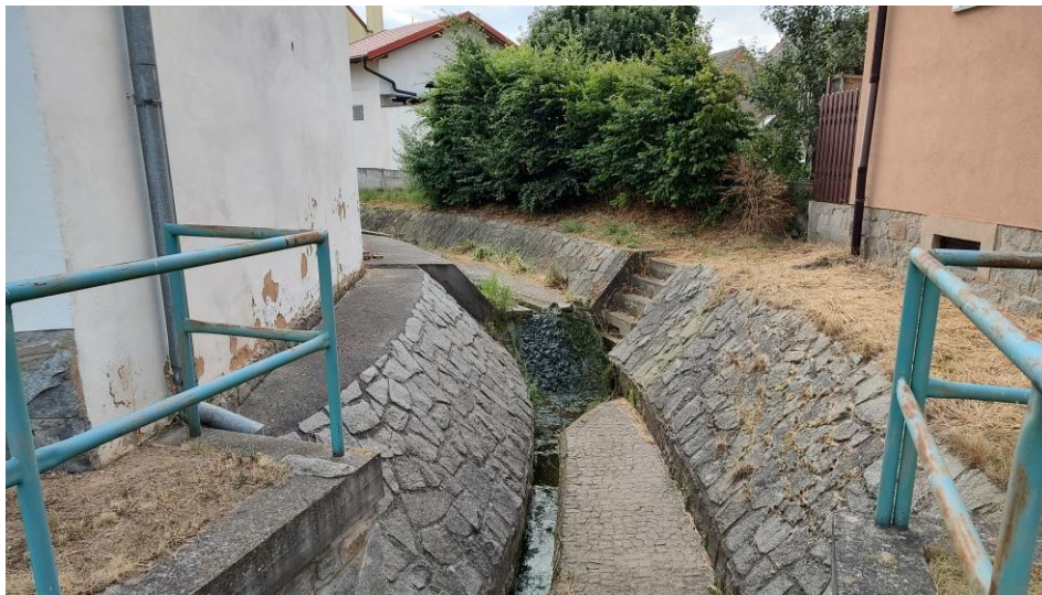
Stupeň ve dně v Liticích u ulice Řečná
