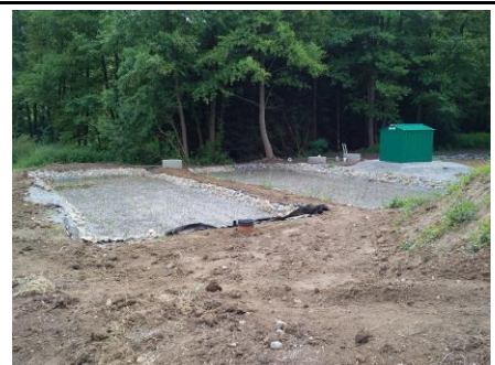
Umělý mokřad na výstupu drenážního systému - výstavba
