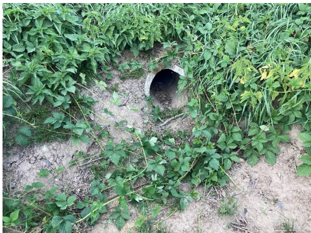
Nekapacitní propustek DN 250 mm na vodoteči IDVT 10280950 nad železniční tratí Nýrsko-Klatovy
