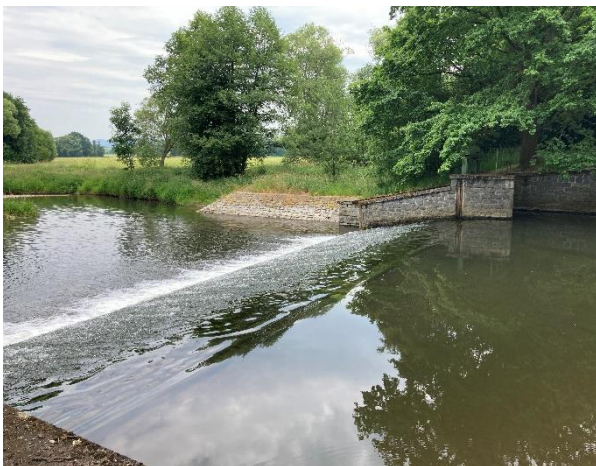
Pevný zděný jez Volenov se štěrkovou propustí na pravém břehu
