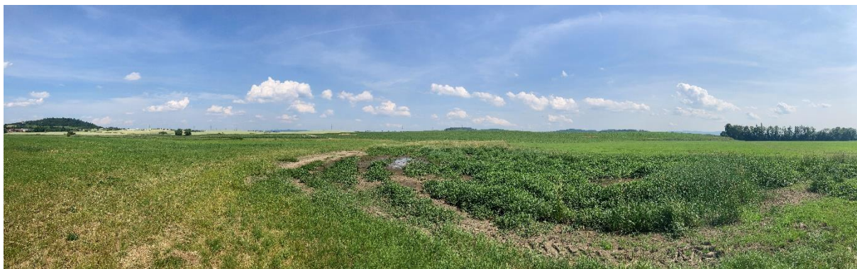
Pohled na zamokřenou plochu na pravém břehu Úhlavy u Dražského Mlýna. Zátopa může být způsobena nefunkčním detailem odvodnění
