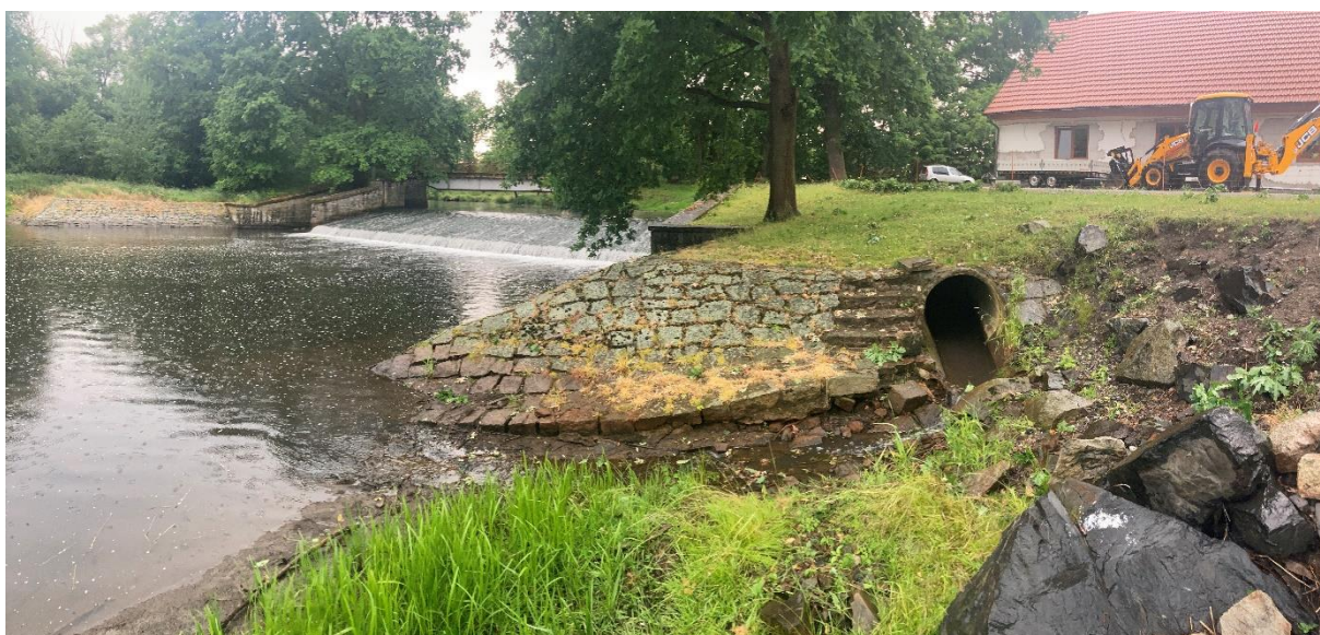
Vyústění dešťové kanalizace z betonového kruhového potrubí DN 1000 pod jezem Volenov, které odvádí dešťové vody z Obce Bezděkov
