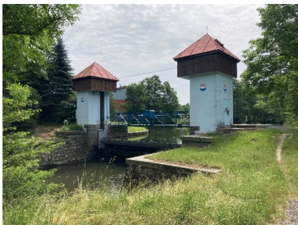
Pohyblivý jez Tajanov se segmentovým uzávěrem
