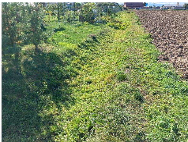
Zatravněný zemní příkop chrání zástavbu Kal před bleskovými povodněmi
