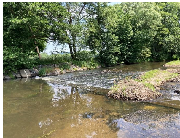
Rekonstruovaný jez Poborovice II s balvanitým skluzem
