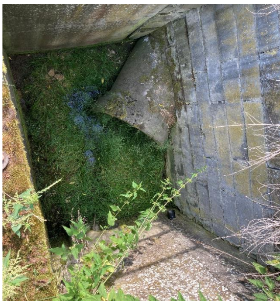
Meliorační šachtice severně od zástavby Beňovy, dno zarostlé vegetací, přesto zjevně stále funkční
