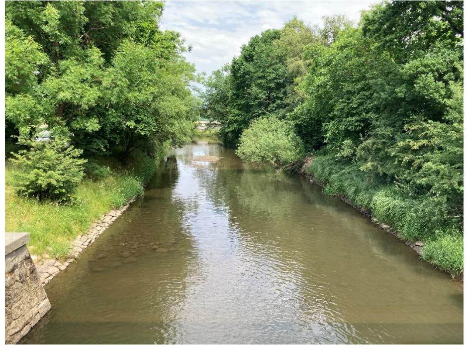
Pohled na tok pod jezem Tajanov. Břehy jsou opevněny kamennou rovnaninou
