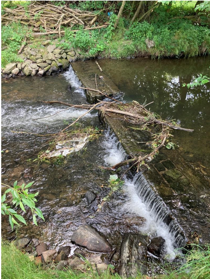
Pohled na umělý kamenný spádový stupeň jižně od obce Poborovice. Na levém břehu dochází k erozi a k obtékání spádového stupně.
