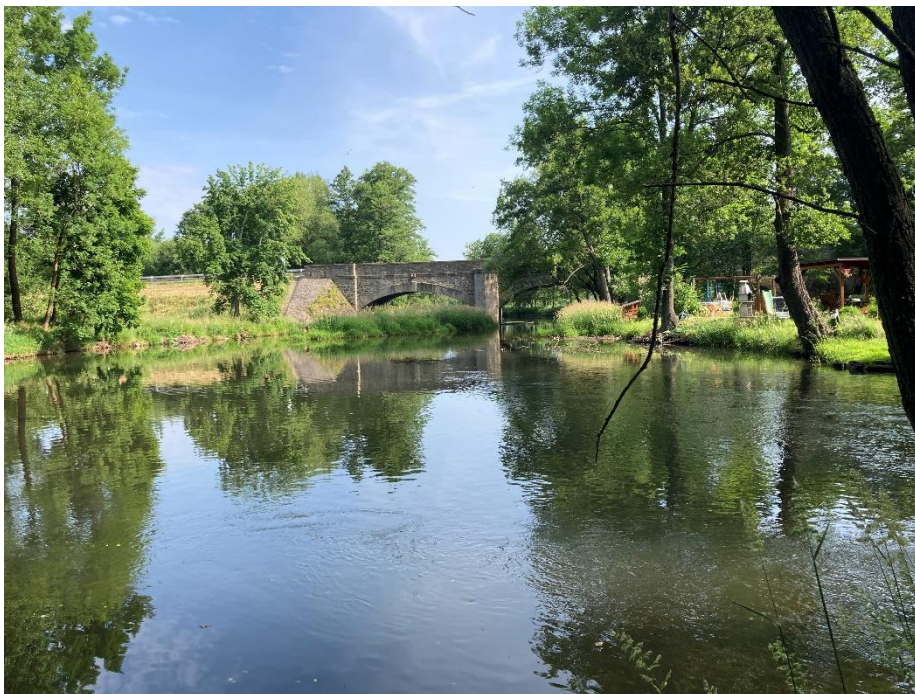
Pohled na krátký rozšířený úsek koryta toku pod mostem silnice I/22. Zde je větší hloubka (okolo 2 m), a také se v tomto místě napojuje zachované slepé rameno Úhľavy evidované jako vodní tok IDVT 12003427
