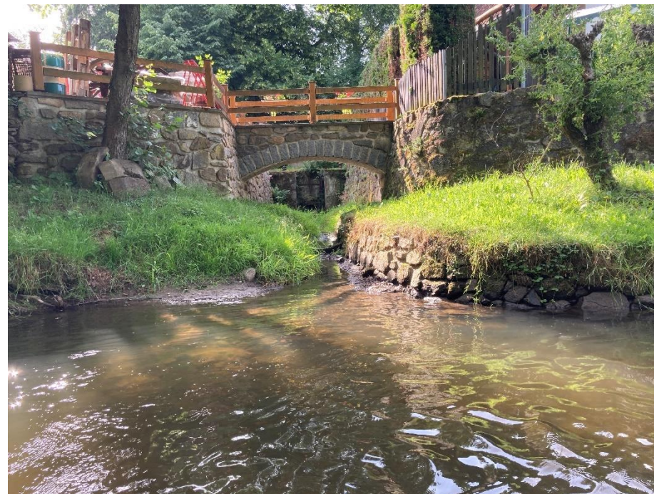
Vyústění melioračního kanálu na pravém břehu jižně od zastavby Beňovy
