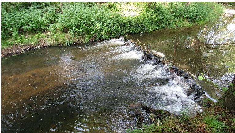
Pohled na přírodě blízký spádový stupeň z kameniva poblíž zastavěné oblasti obce Poborovice
