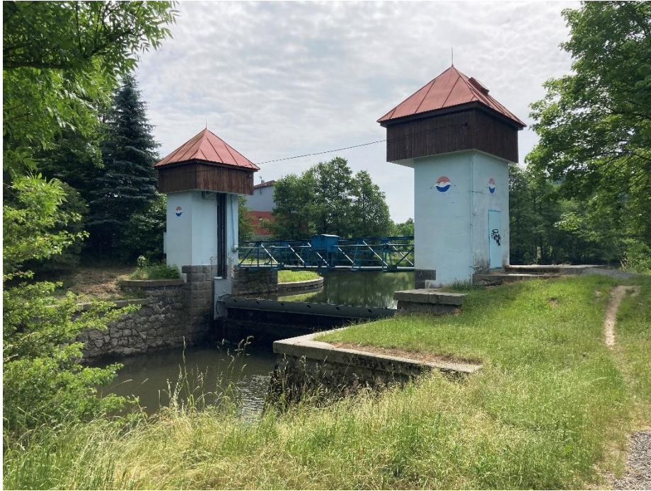
Pohled na segmentový jez Tajanov (km 63,592)
