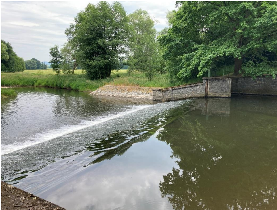
Pohled na zděný jez Volenov se štěrkovou propustí na km 68,647 těsně před vtokem do zájmového území. Vzdouvací objekt nemá vybudován rybí přechod.
