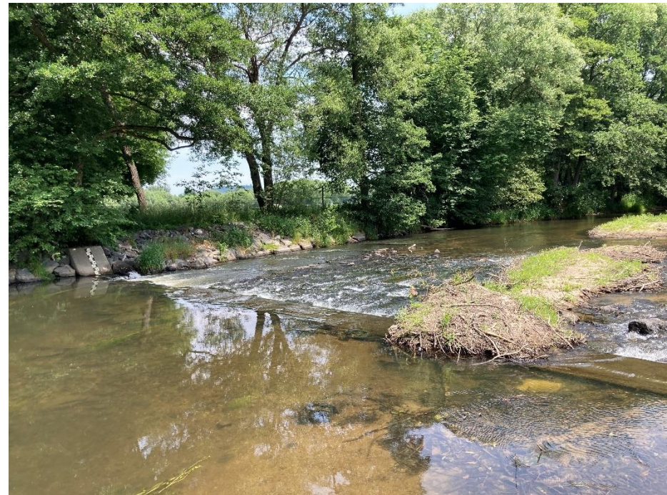
Pohled na jez Poborovice 2 na ř. km 68,165, který byl rekonstruován a byl vybudován rybí přechod
