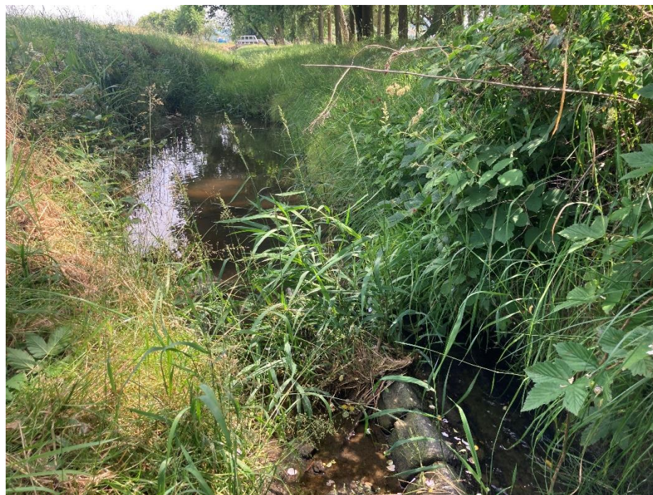
Pohled na přirozeně vytvořenou tůň v technicky upraveném korytě a vybočení toku z opevnění kamennou dlažbou
