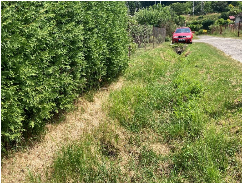
Pohled na zatravněný odvodňovací příkop trojúhelníkového příčného průřezu
