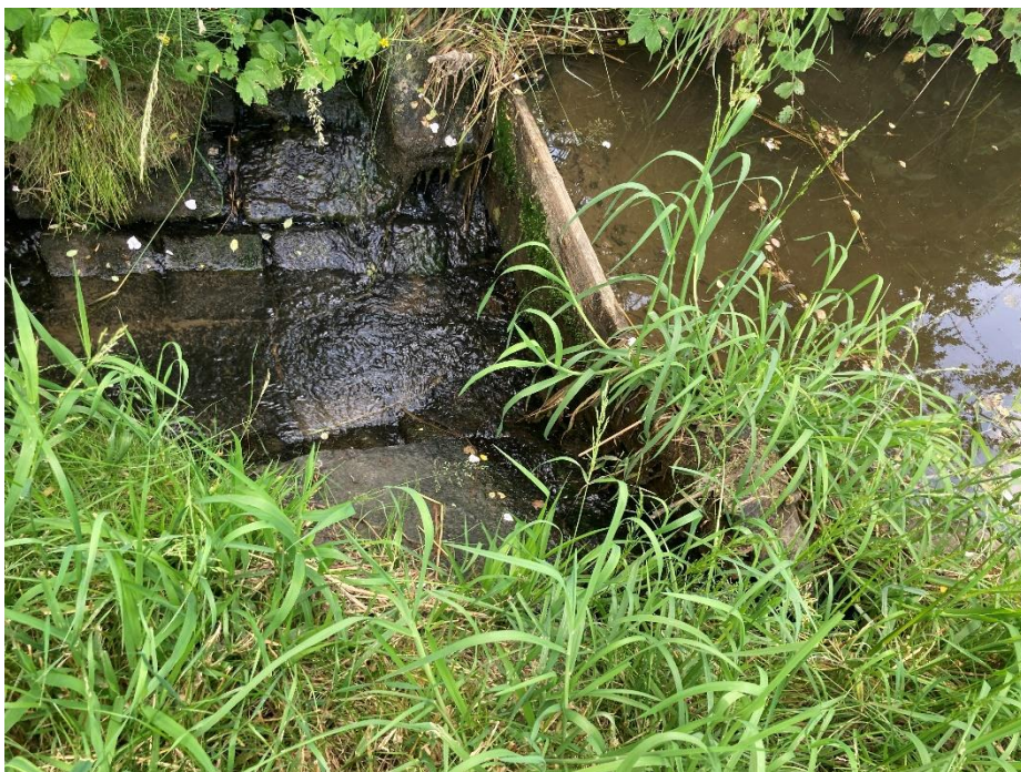
Umělý spádový stupeň vytvořený pomocí dřevěného prkna a technické opevnění toku kamennou dlažbou před křížením se silnicí Tupadly-Tajanov
