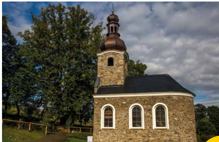
Novostavba kaple Panny Marie Bolestné u Hartmanic
