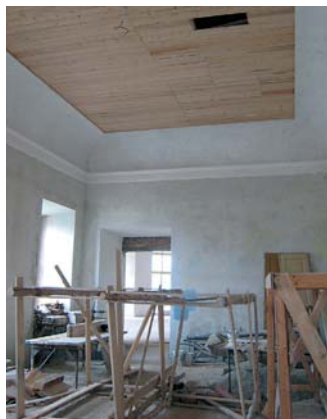
Rada sálů už prošla rozsáhlou rekonstrukcí.
