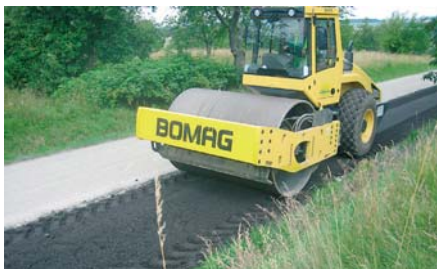
Nová technologie opravy silnice za studena se vyzkoušela na Tachovsku. FOTO ARCHIV
