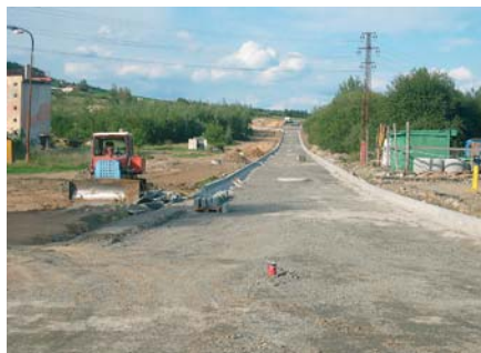
Stavba důležité komunikace na okraji Klatov roste vysokým tempem.
