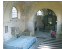
Záchraně práce se nyní soustřeďují na vnitřní prostory kostela.
