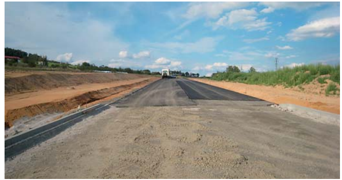
Plzeňský kraj investuje nemalé částky peněz na stavbu průtahů.
