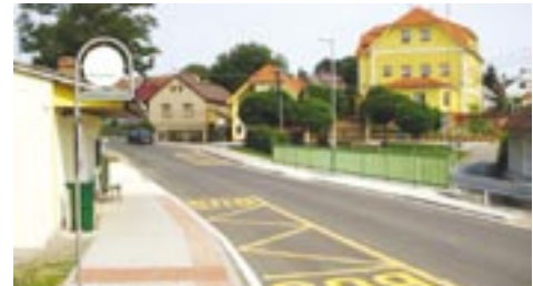
Opravený most v Němčovicích.
