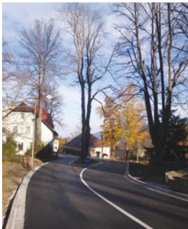
Rekonstrukce průtahu obcí Hojsova Stráž na Klatovsku trvala tři měsíce. Snímek je z přelomu října a listopadu. Tehdy už byla hotová silnice, zbývalo ještě dokončit chodníky.
