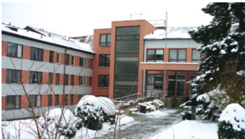
Objekt hornobřízského domova je tvořen třemi propojenými pavilony.
