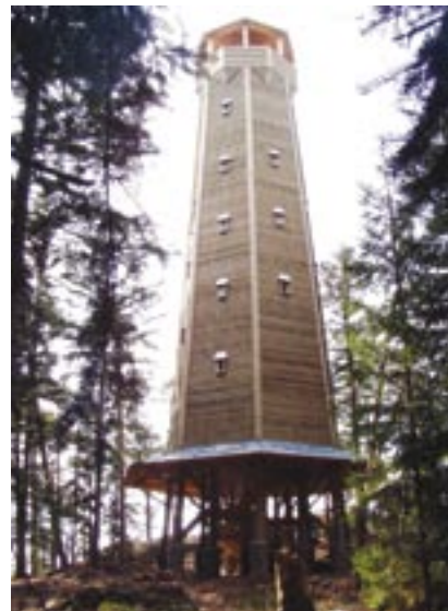
Nová rozhledna na vrchu Sedlo nedaleko Sušice je postavena převážně ze dřeva, a tak skvěle zapadá do okolního lesního porostu.
