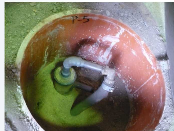
Opravený propařovací vrt P-5
