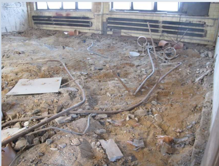
Demolice podlah a odběr vzorků zemin
