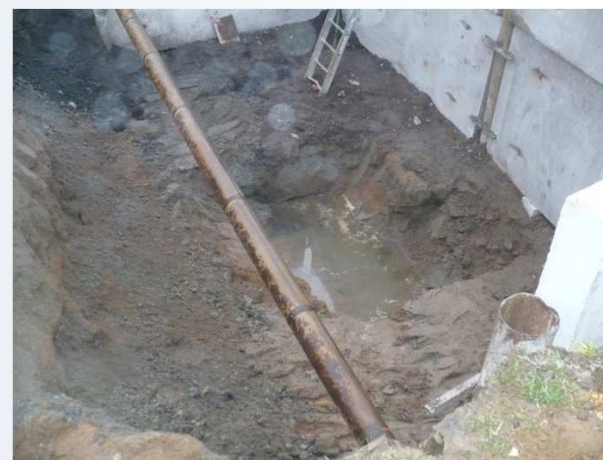
Mělká zvodně SZ jámy
