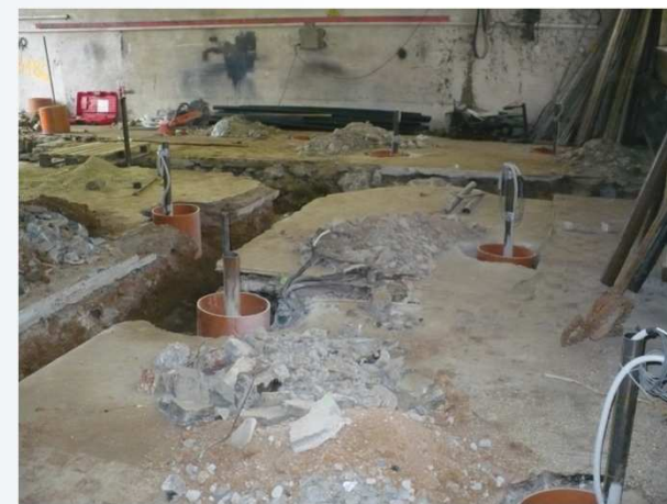
Realizace rozvodů v benzínové hale
