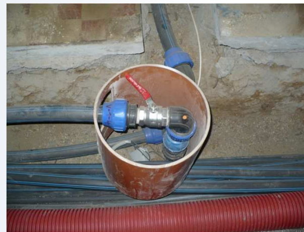
Připojení ventingového vrtu
