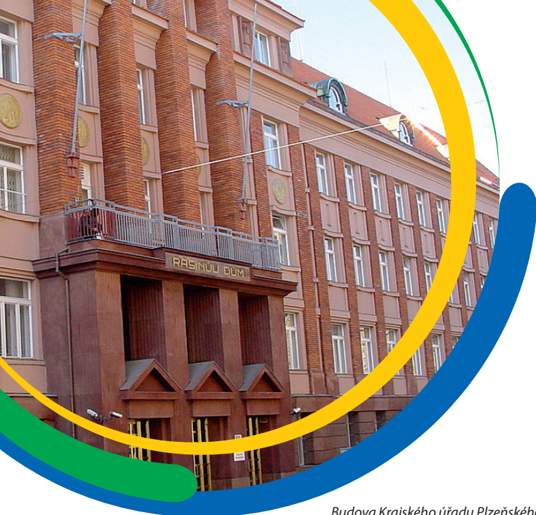
Budova Krajského úřadu Plzeňského kraje
