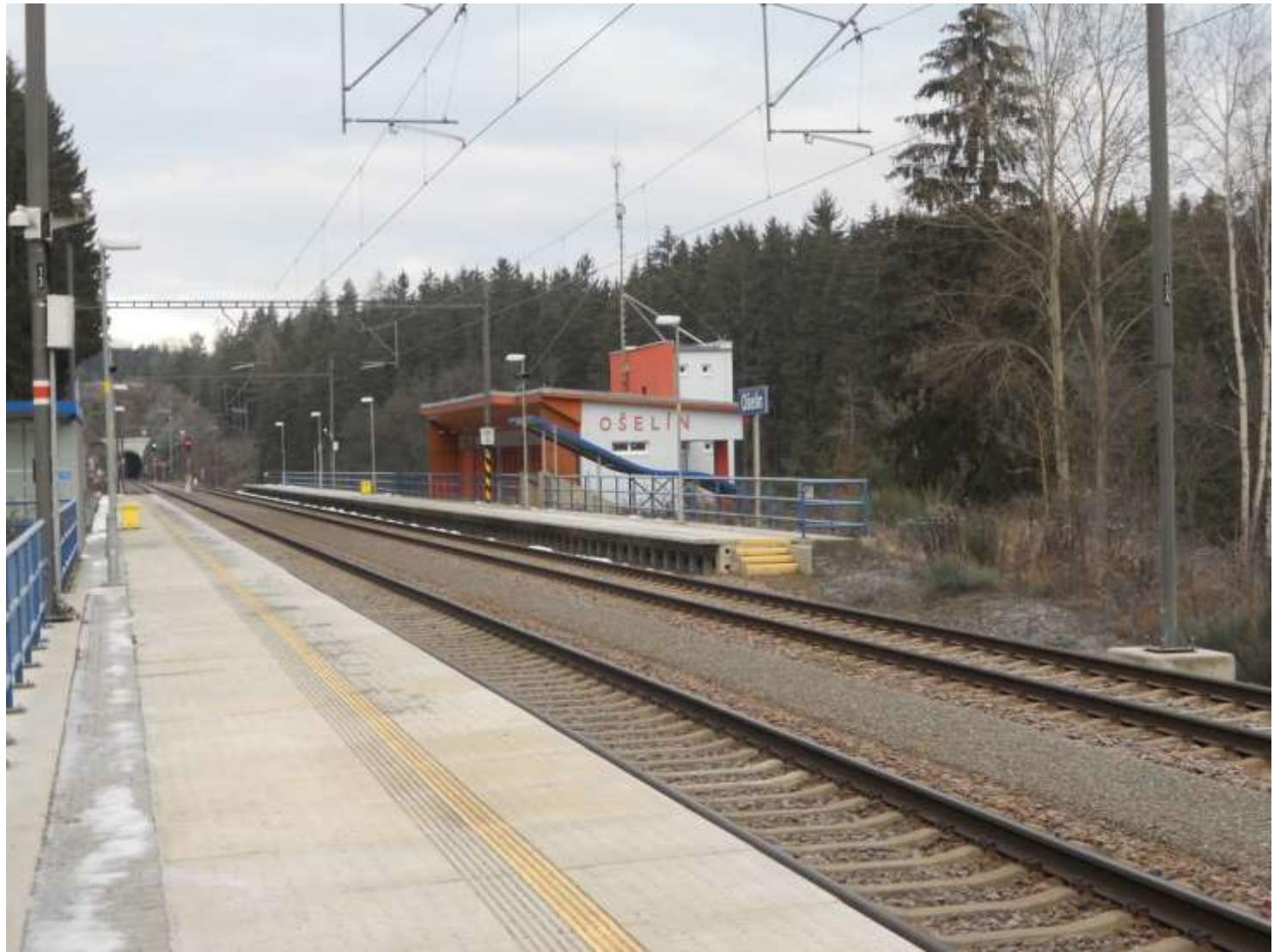
nástupiště na zastávce Ošelín
